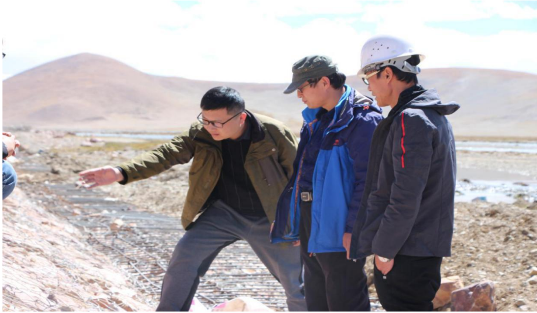
9月27日与建管中心共同检查措勤县曲洛乡吃阿玖防洪工程建设质量、安全、进度（摄影：建管中心）
