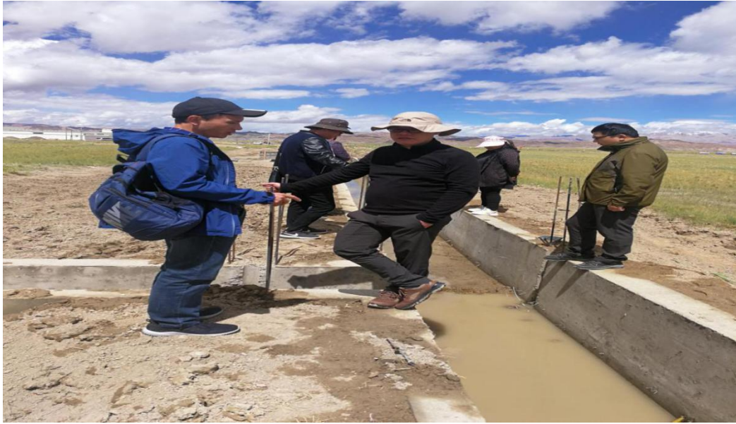
9月10日 在日土县日松乡德汝村水土保持生态修复工程项目工地调研、技术指导（摄影：周世虎）
